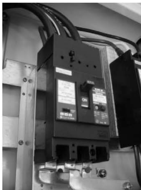
漏電遮断機（漏電ブレーカ）
